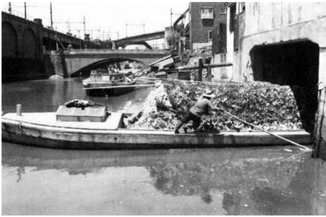
fig.3 万世橋塵芥取扱場。『東京都清掃事業百年史』2000年、より。 Waste Disposal Center at Mansei-bashi Bridge
