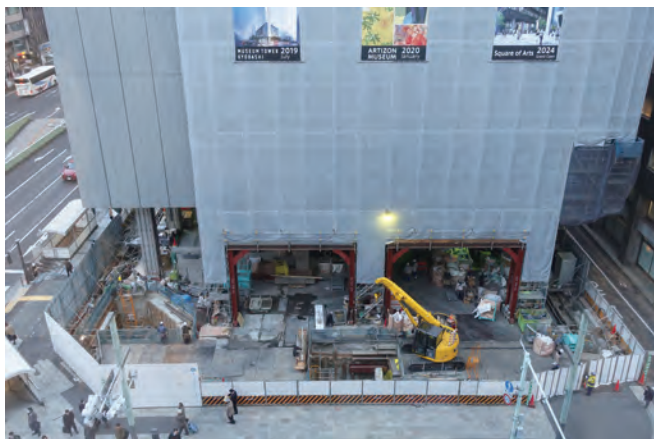
中央通り側ビル低層部の施工開始
