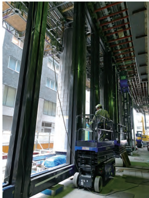
1階大回転扉設置の様子
