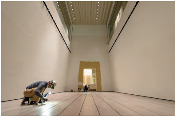
展示室最終仕上げの様子
