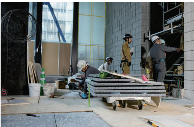
ミリ単位で設置される石積みの壁面と床材
