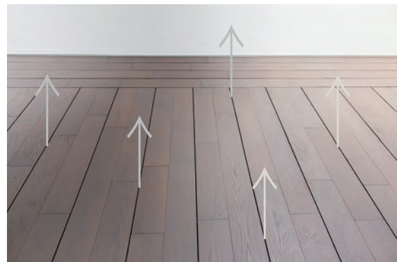
フローリング床の目地を吹き出しに利用した置換空調による展示室
