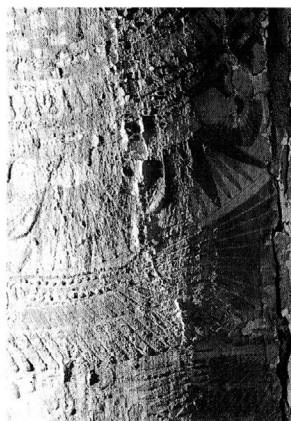
fig.6 同部分測光線図 (絵具層浮き上がりの様子)
