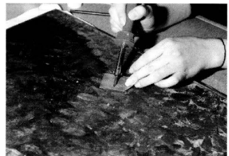
fig.10 絵具の浮きを接着
